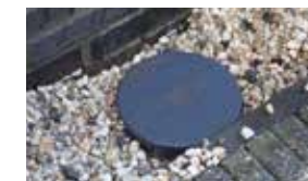
Door het afneembare deksel maak je de zandvangervanger eenvoudig schoon.
